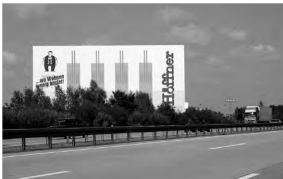
Abb.3.2-2: Großflächige Einzelhandelseinrichtungen haben aufgrund der Höhe und kompakten Form des Baukörpers oft eine größere Fernwirksamkeit - sie markieren Einkaufslandschaften, Saalepark, Günthersdorf (Foto: C. Schmidt).
